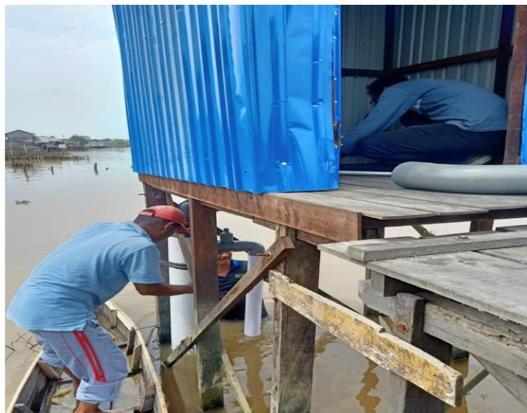
Gambar 3 Pemasangan Tripikon
